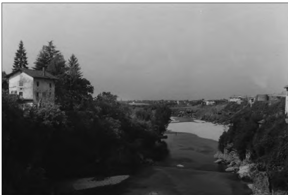
Sl. 1: Pogled na Nadižo s Hudičevega mosta v Čedadu (slika hrani Odsek za zgodovino in etnografijo pri Narodni in študijski knjižnici v Trstu).
