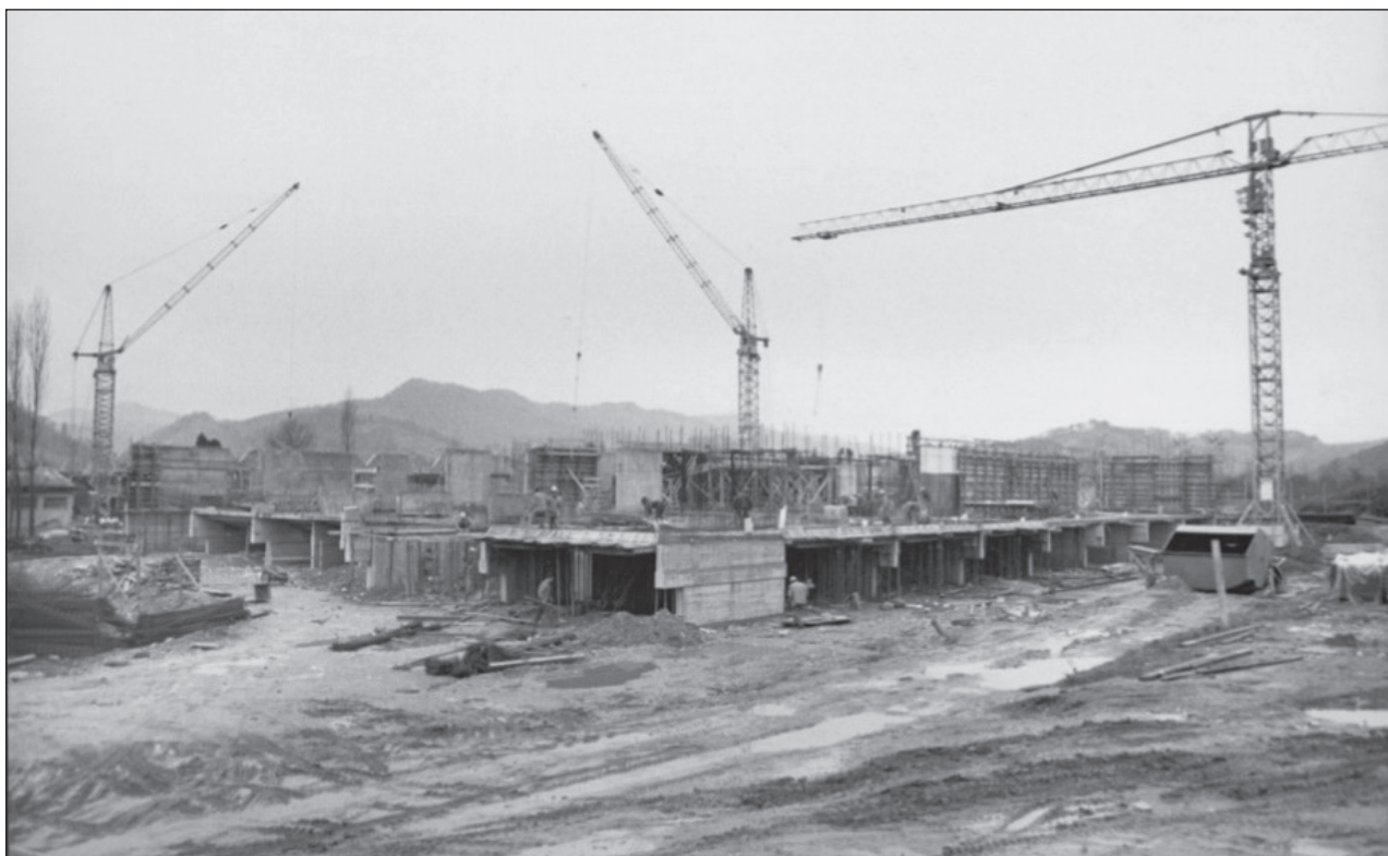
Slika 3: Gradnja nove stavbe Pedagoške akademije v Mariboru. 45
