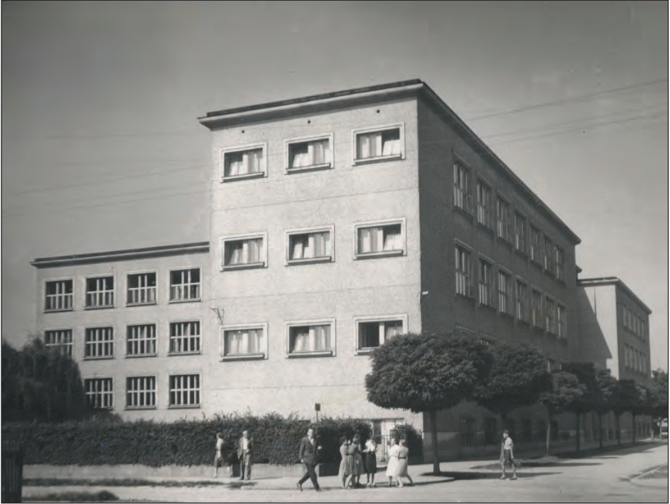
Sl. 6: Novo šolsko poslopje ob Žolgerjevi ulici (PAM-1889, 4–38).
