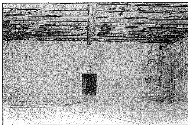
Koper, Pretorska palača, zahodna stena dvorane Velikega sveta (fototeka MZVNKD).
