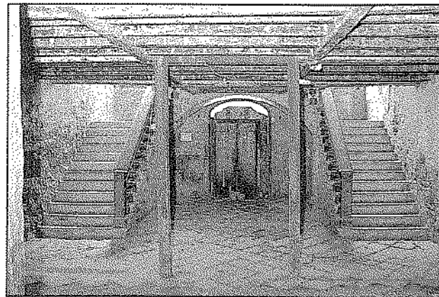
Koper, Kreljeva 6, vhodna veža s stopniščem (fototeka MZVNKD).
