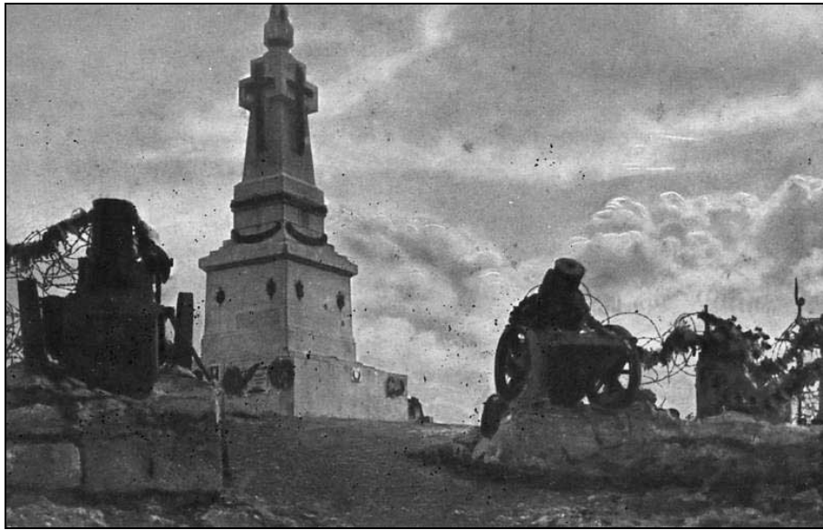
Fig. 1: Cimitero degli Invitti della III Armata, Colle Sant'Elia. La cartolina reca sul recto la scritta: La «Zona Sacra dell'Eroismo e del Sacrificio. Redipuglia, L'Ossario dei Caduti» (Collezione Mastrociani-Todero).
